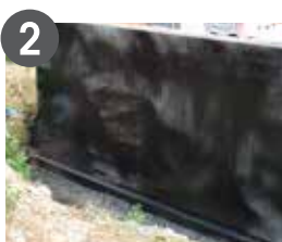
2 Grundierung (Komp. A) aufsprühen
