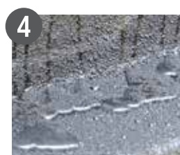
4 Wasser wird aus der Abdichtung gepresst
